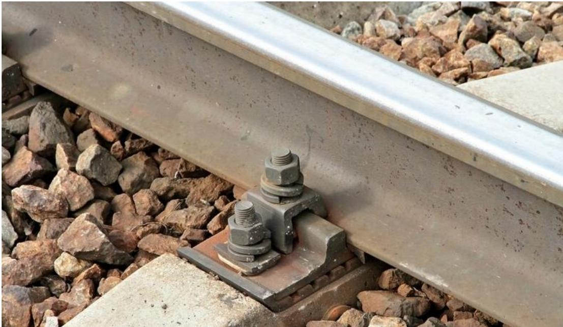
Рисунок 3 – промежуточное скрепление КБ-65
