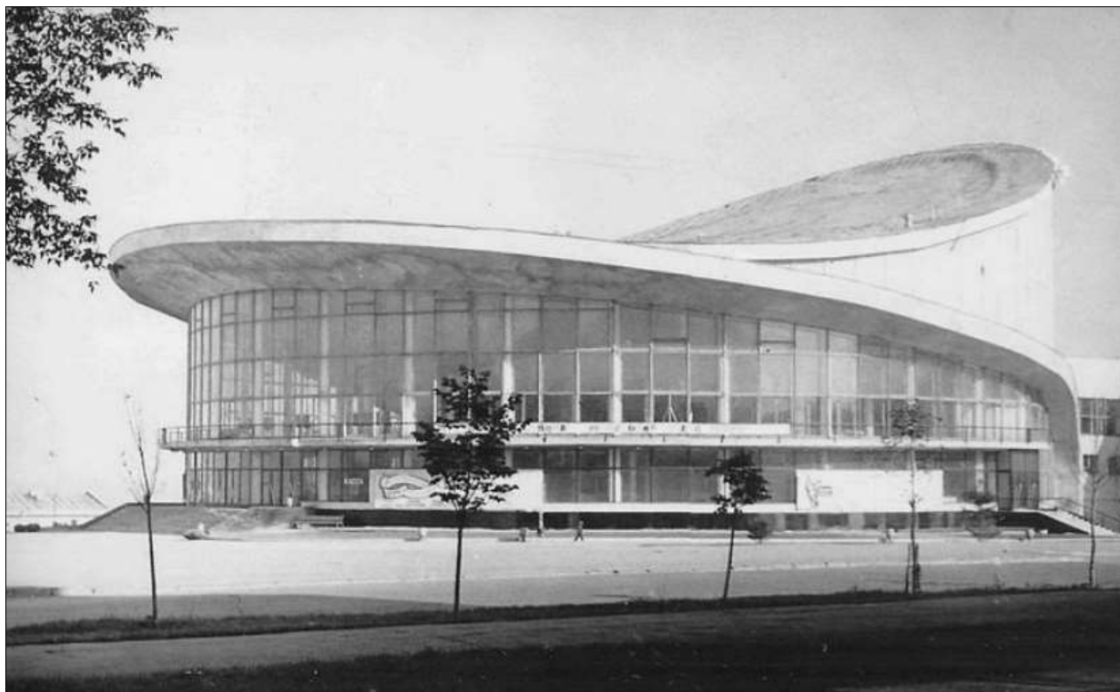
Рис. 3. Внешний вид цирка в стадии завершения работ
