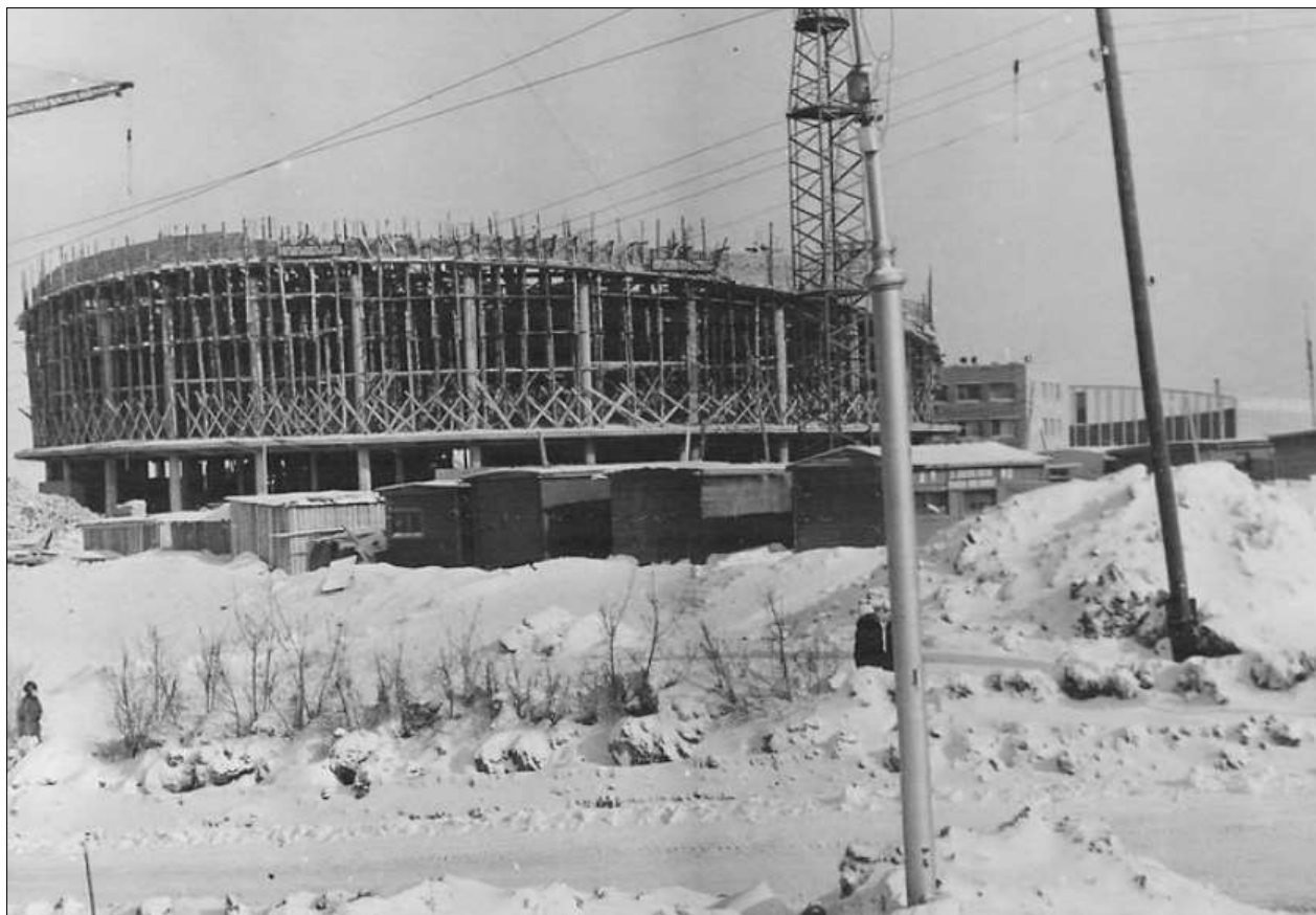
Рис. 2. Строительство цирка на углу Молодогвардейской и Маяковского
