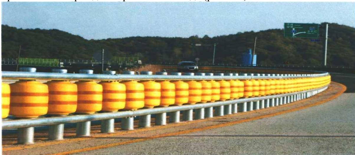
Рис.1.Общий вид роликового барьерного ограждения.
