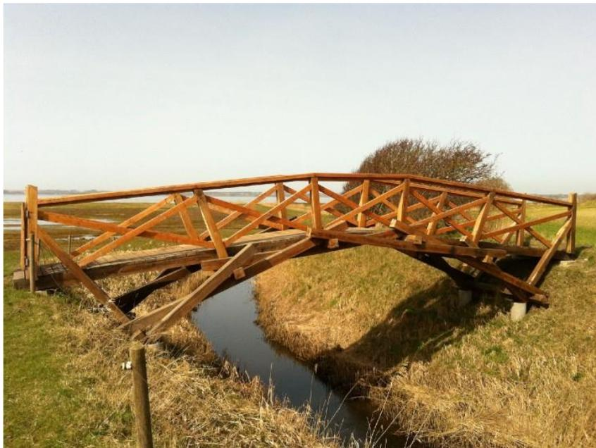
Предназначенный для того, чтобы помочь армиям пересекать водоемы, мост состоит из нескольких зубчатых деревянных столбов, возведенных без необходимости каких-либо винтов или других креплений.
