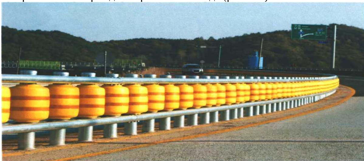
Рис.1.Общий вид роликового барьерного ограждения.
