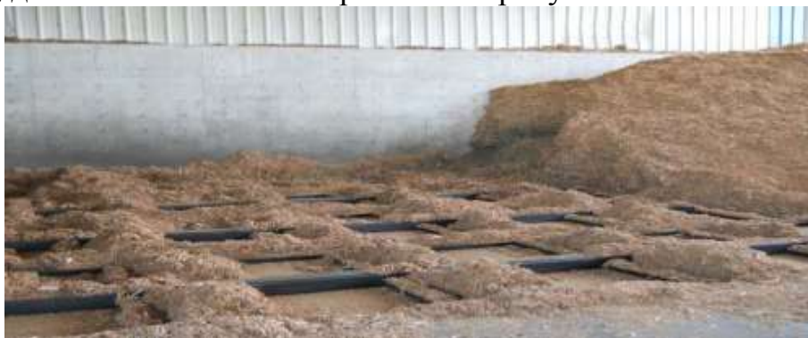
Рисунок 4 – Гидравлический толкатель (стокер)
