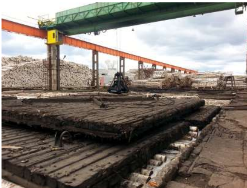
Рисунок 3 – Склад и гидротермический бассейн
